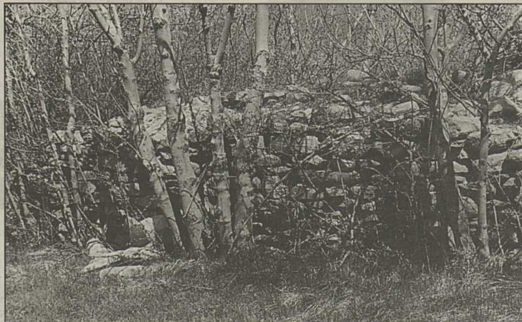
Mit immer stärkerem Griff unklammern die Bäume die Mauerteile. Gemessen an der historischen Bedeutung und den steigenden Kosten, die eine Verzögerung der Sanierung mit sich bringen, müsste mit der Entfernung der schädigenden Bäume noch heute begonnen werden.
